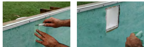
Fixing of the skimmer joint Fijación de la primera junta del skimmer Fixation du 1er joint de skimmer Befestigung der ersten Dichtung des Skimmers Fissaggio del primo giunto dello skimmer Bevestiging van de eerste pakking van de skimmer Fixação da primeira junta do skimmer
