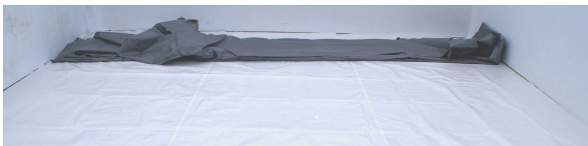
Abbildung 32 – Entfalten der Folienauskleidung
