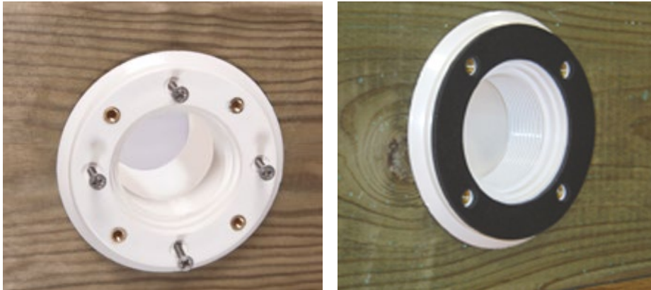
Abbildung 23 – Montage der Ausstoßdüse und seiner Dichtung
