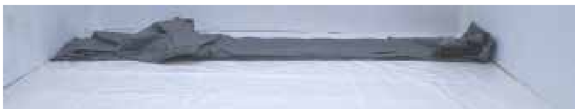
Abbildung 32 – Entfalten der Folienauskleidung
