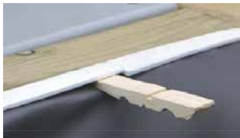
Abbildung 31 – Verkeilung der Folienauskleidung mithilfe der halben Wäscheklammern
