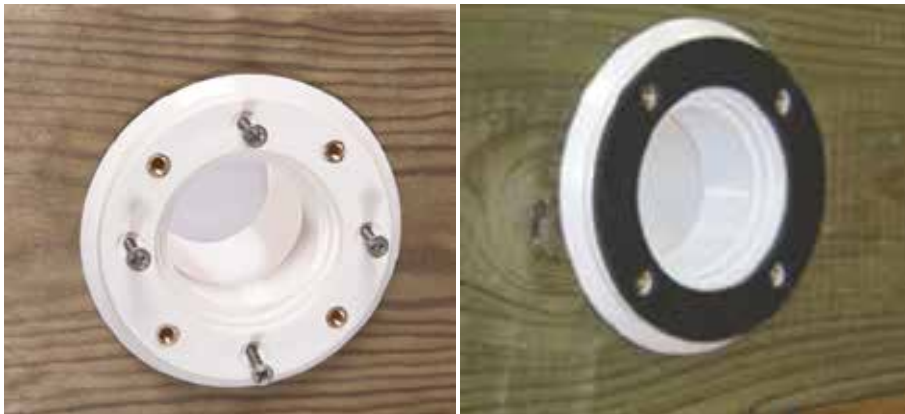
Abbildung 24 – Montage der Ausstoßdüse und seiner Dichtung
