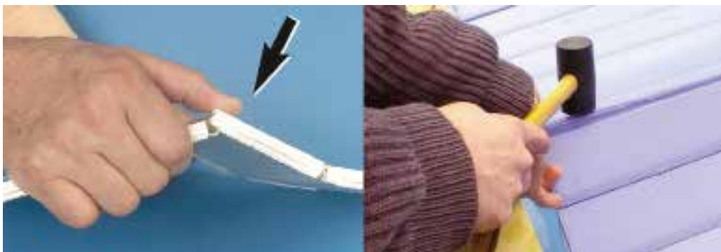
Abbildung 44 – Einklemmen der Lamellen
