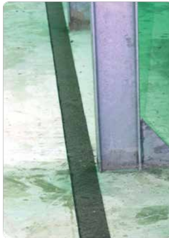
Abbildung 8 – Anbringen der Bitumenstreifen
