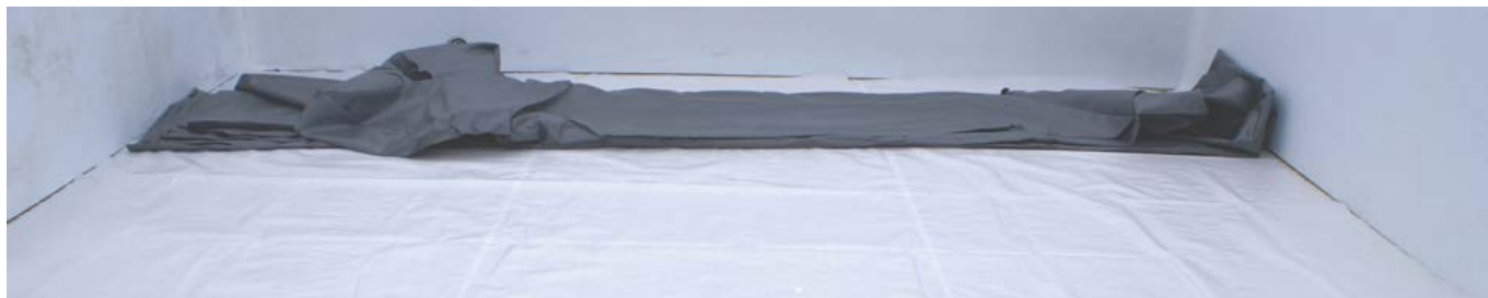
Abbildung 34 – Entfalten der Folienauskleidung
