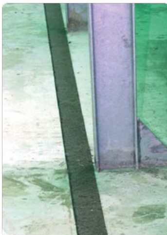
Abbildung 9 – Anbringen der Bitumenstreifen
