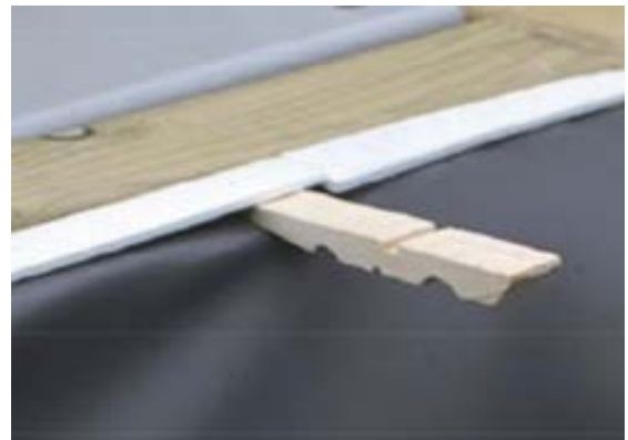
Abbildung 33 – Verlegung der Folienauskleidung mithilfe der halben Wäscheklammern
